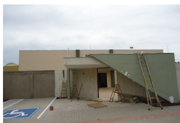
Fachada externa do novo prédio do GAECO.
